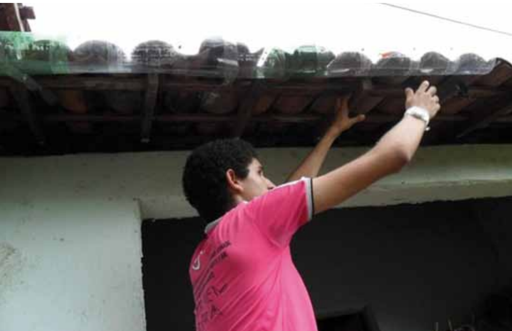
Figura 1 Instalação da calha alternativa pelo estudante Gabriel dos Santos Fonte: Santos, 2011
