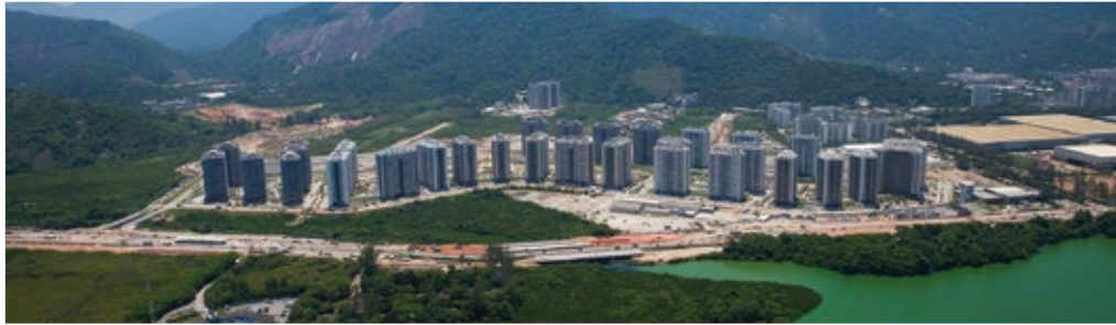
Concrete Recycling - Ilha Pura - Rio de Janeiro / RJ.
