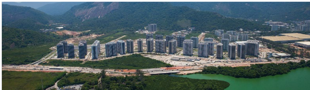
Recicladora de Concreto - Ilha Pura - Rio de Janeiro / RJ.
