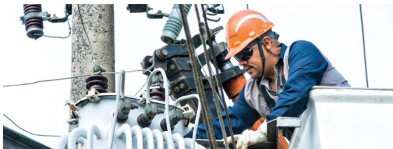
Manutenção na rede elétrica da AES Eletropaulo
