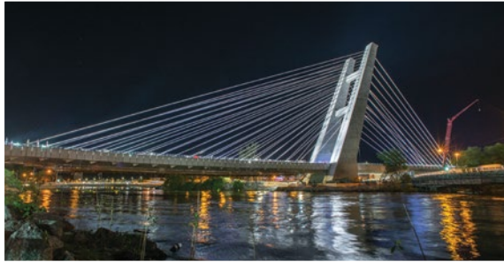
Iluminação cênica da ponte estaiada no Metrô Linha 4 Sul – Rio de Janeiro / RJ.
