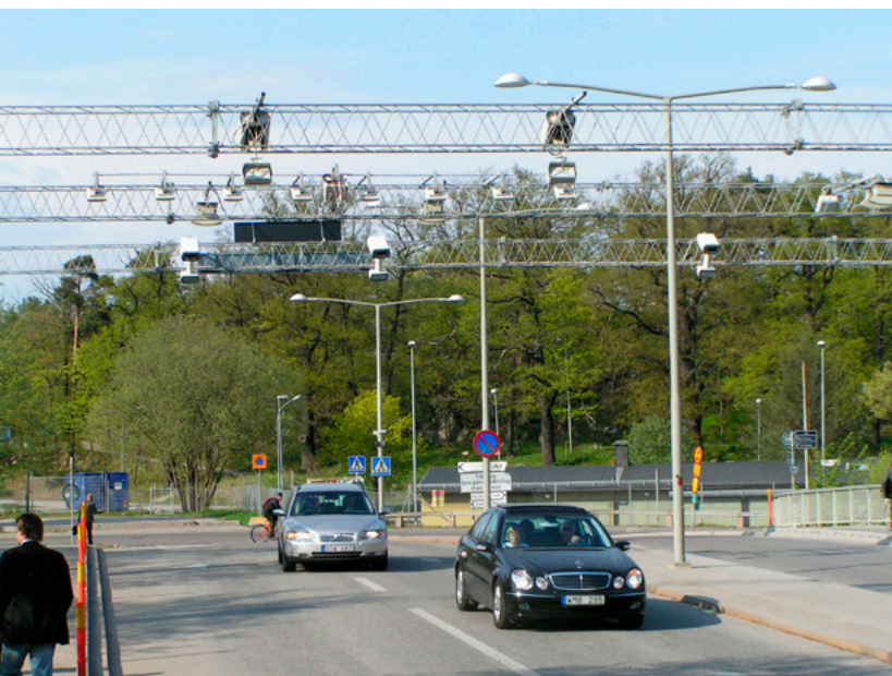
Figura 56: Pontos de verificação da cobrança da tarifa de congestionamento fornecem dados úteis para a avaliação do planejamento e da política, Estocolmo.
