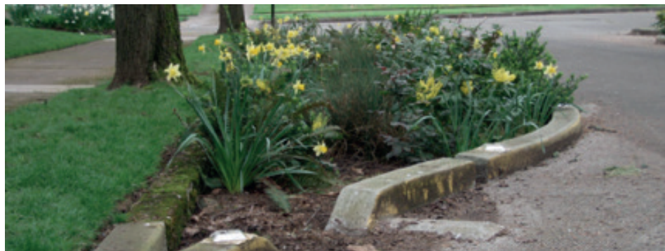
Jardim de chuva instalado na via com redução de velocidade de tráfego
