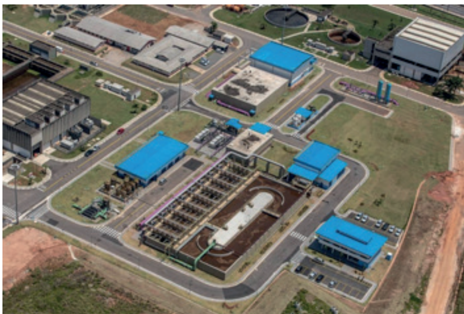
Visão geral da ETE Aquapolo Visão do Polo Petroquímico do ABC
