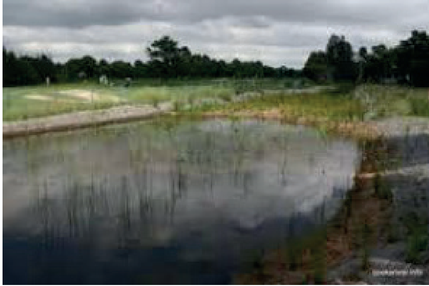
Sistema implantado já em operação
