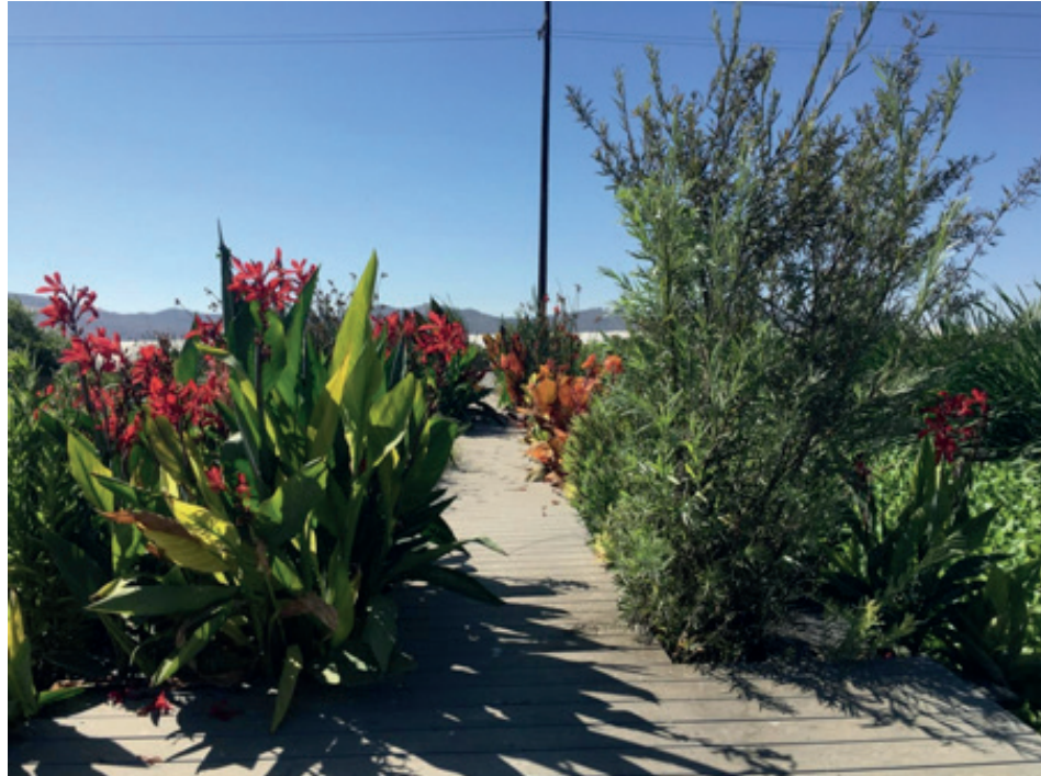
Passarela interna cruzando os tanques de tratamento com plantas aquáticas
