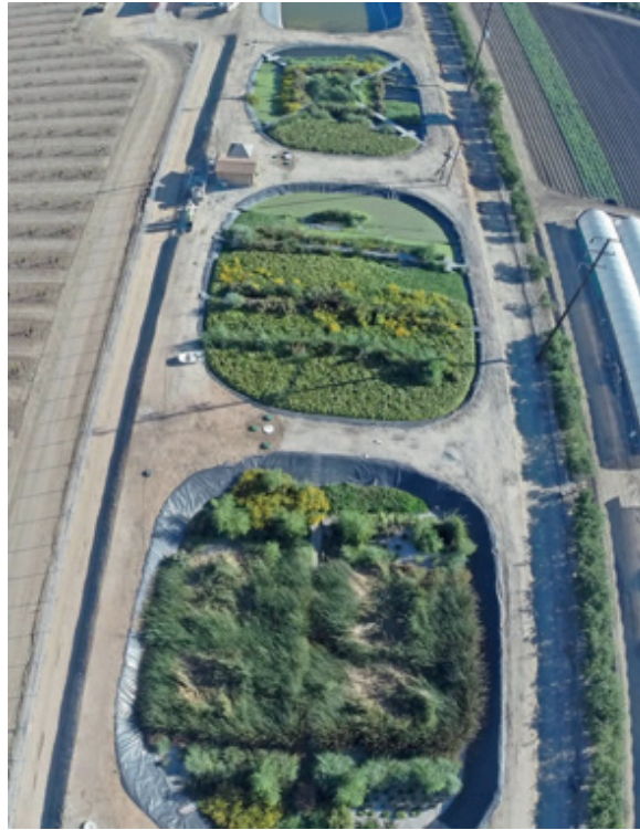
Vista aérea do sistema de tratamento
