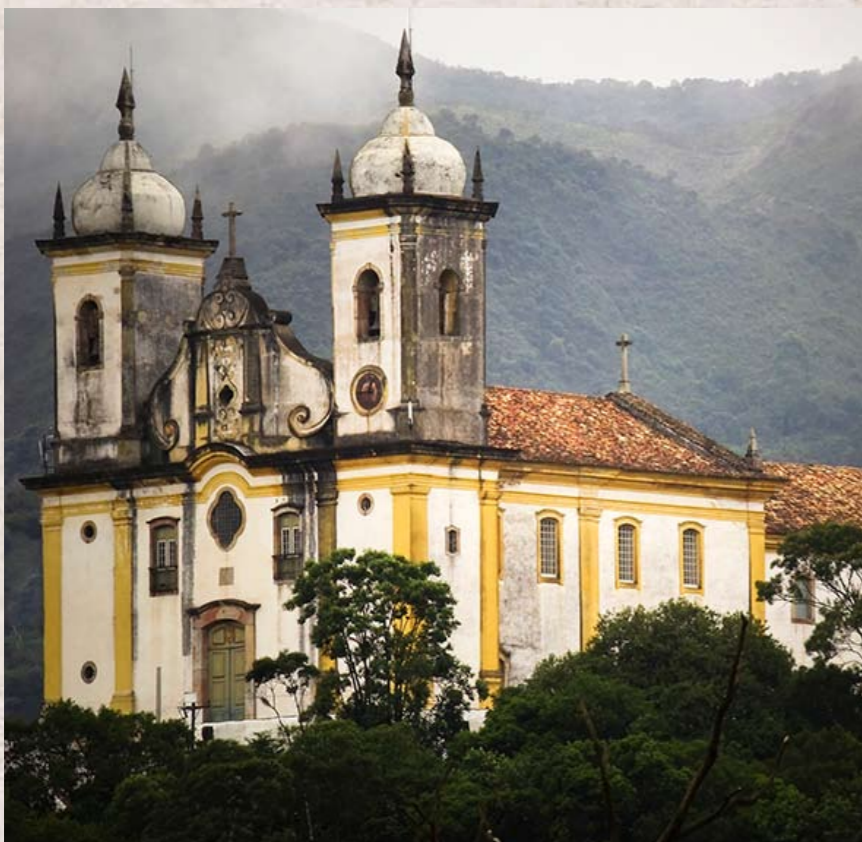
Detalhe da Igreja de São Francisco de Assis, na cidade de Ouro Preto, projeto de Antônio Francisco Lisboa, o Aleijadinho
