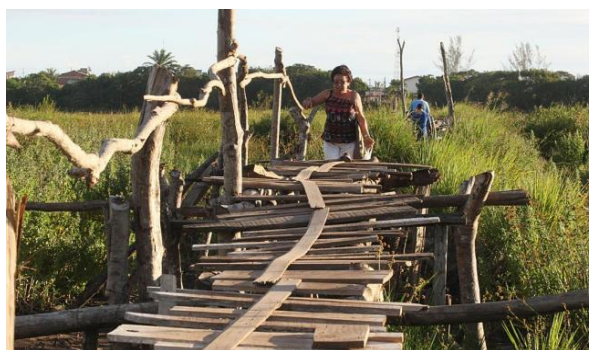
Figura 24 - Ponte sobre o Manguê do Rio Capivara, Rancho Alegre, Arembepe Camaçari
