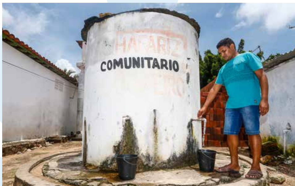
Figura 17 Chafariz comunitário da Comunidade de Coqueiro-Caucaia/CE.
