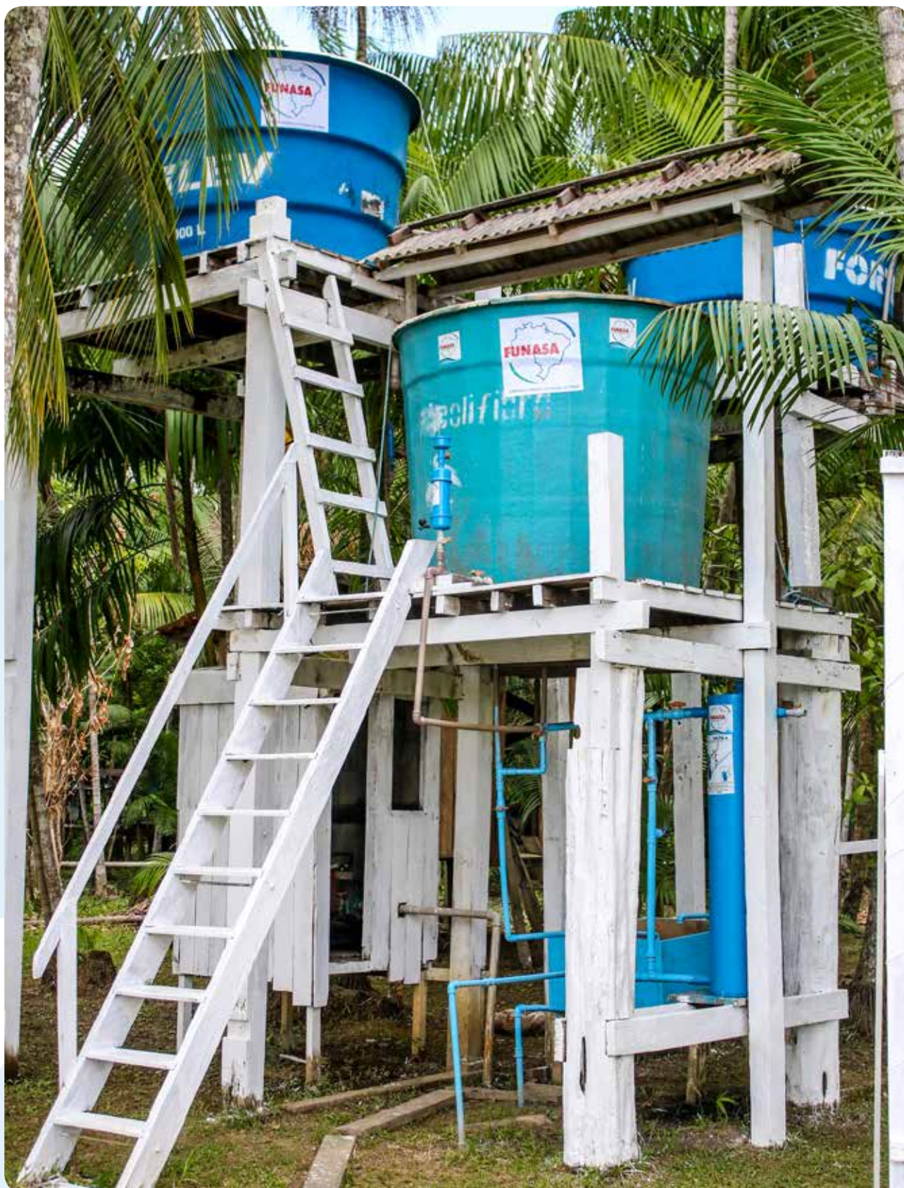
Figura 7 Solução Alternativa de Tratamento de Água (SALTA-z) montada.
